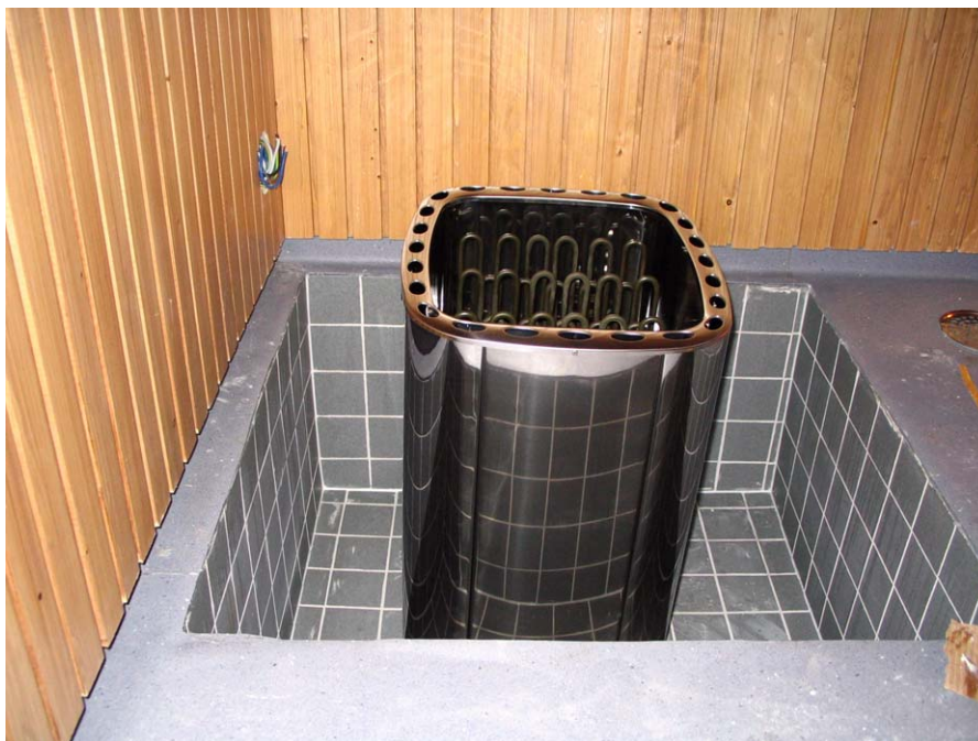
Kuva 30. Kiuas paikoillaan (Kuhmon palvelutalo Kultakuusi)
