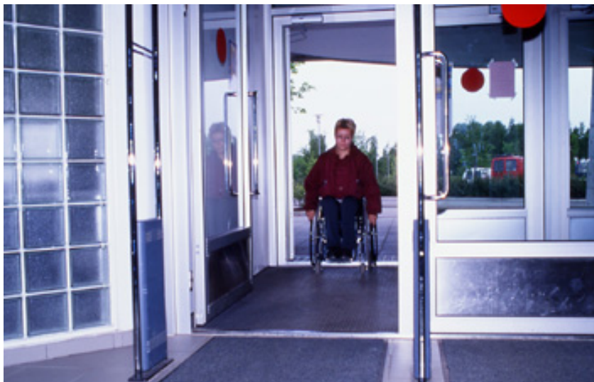
Kuva 10. Ulko- ja tuulikaapin ovet avautuvat automaattisesti [2.]
