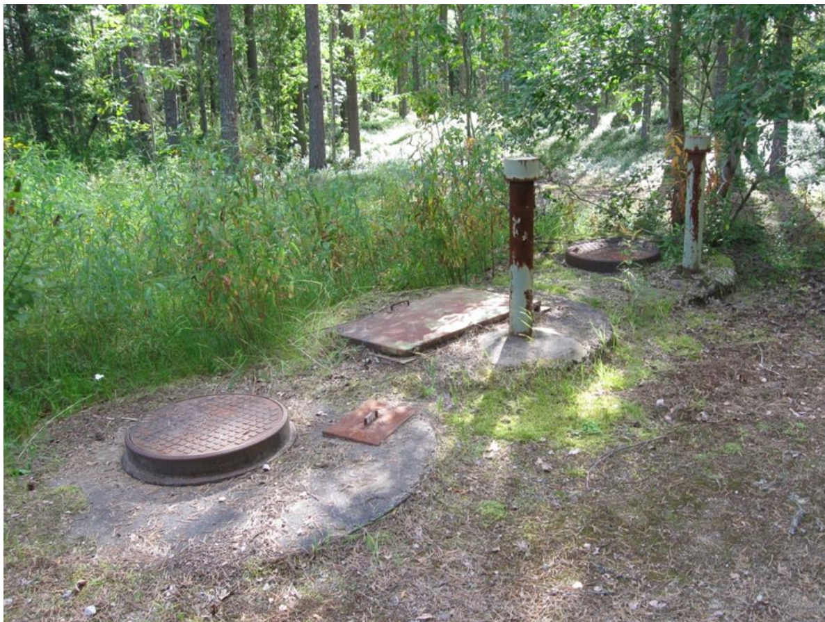
Kuva 7. Nykyiset saostuskaivot (Juntunen 2015-07-31)
