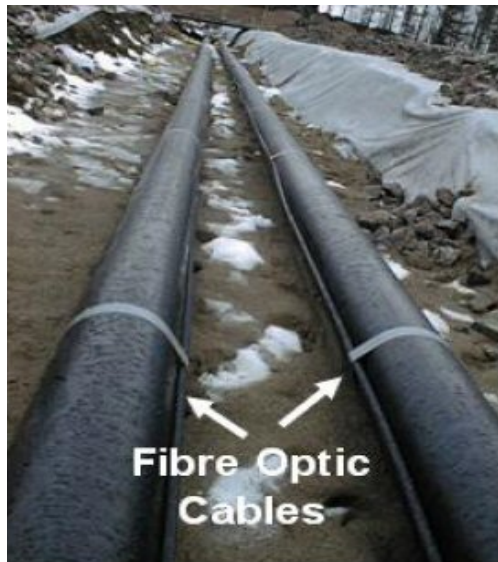
Kuva 35. Optisen kuidun asennus kaukolämpöputkeen. [20]
