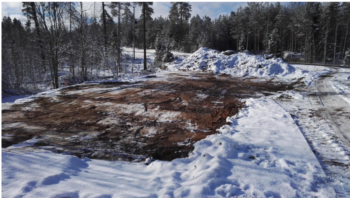
Figur 14 (Den befintliga massan bortgrävd)
