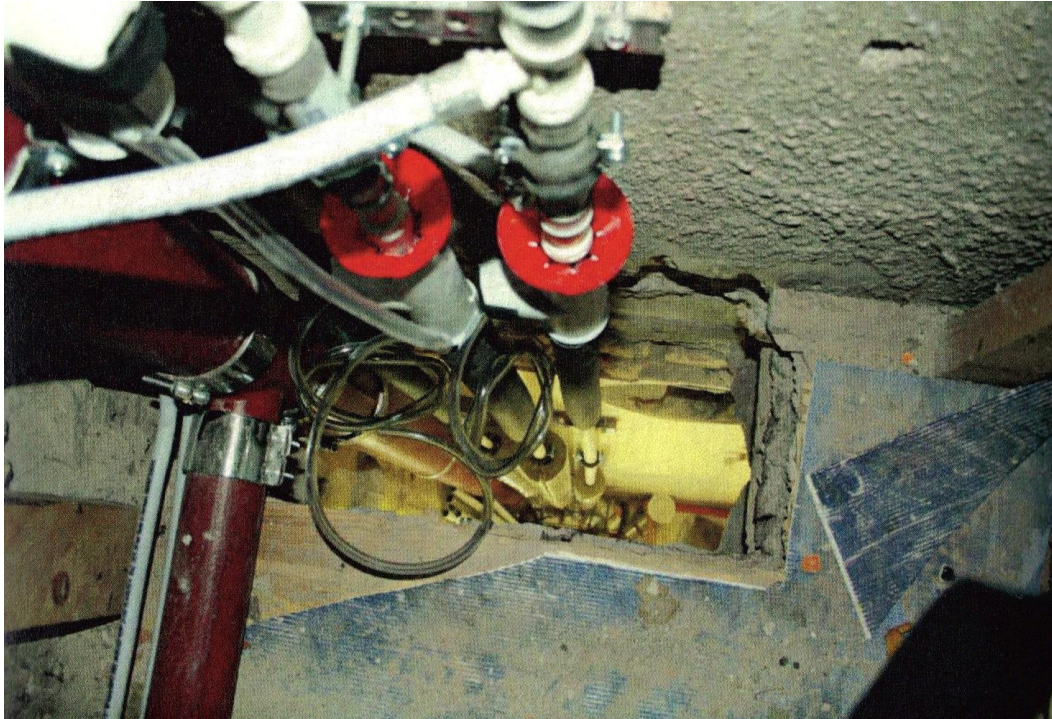
Kuva 5. Pystylinjoja varten kerrosten välillä oleva läpivientiaukko [7, s. 45].
