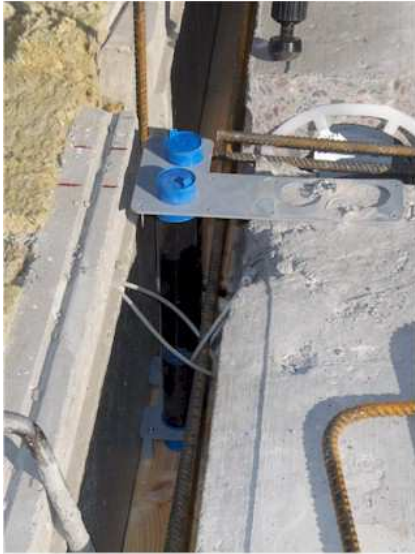
Kuva 14. Sewatek-läpivienti ontelolaatassa. [14.]
