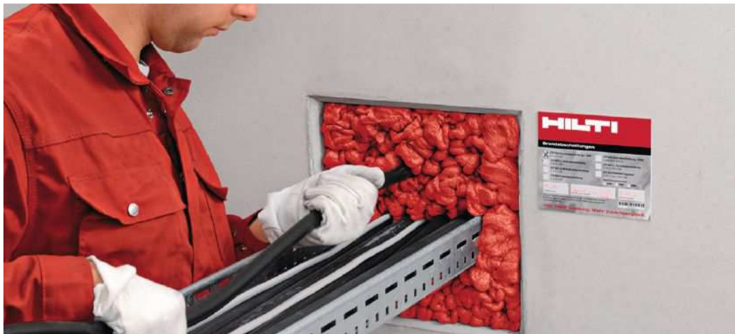
Kuva 6. Palokatko on tehty Hilti CFS-F FX laajenevalla palokatkovaahdolla. [12.]
