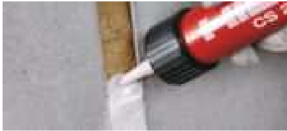
Kuva 12. Hilti Oy:n palokatkomassalla seinien välin saumaus. [12.]
