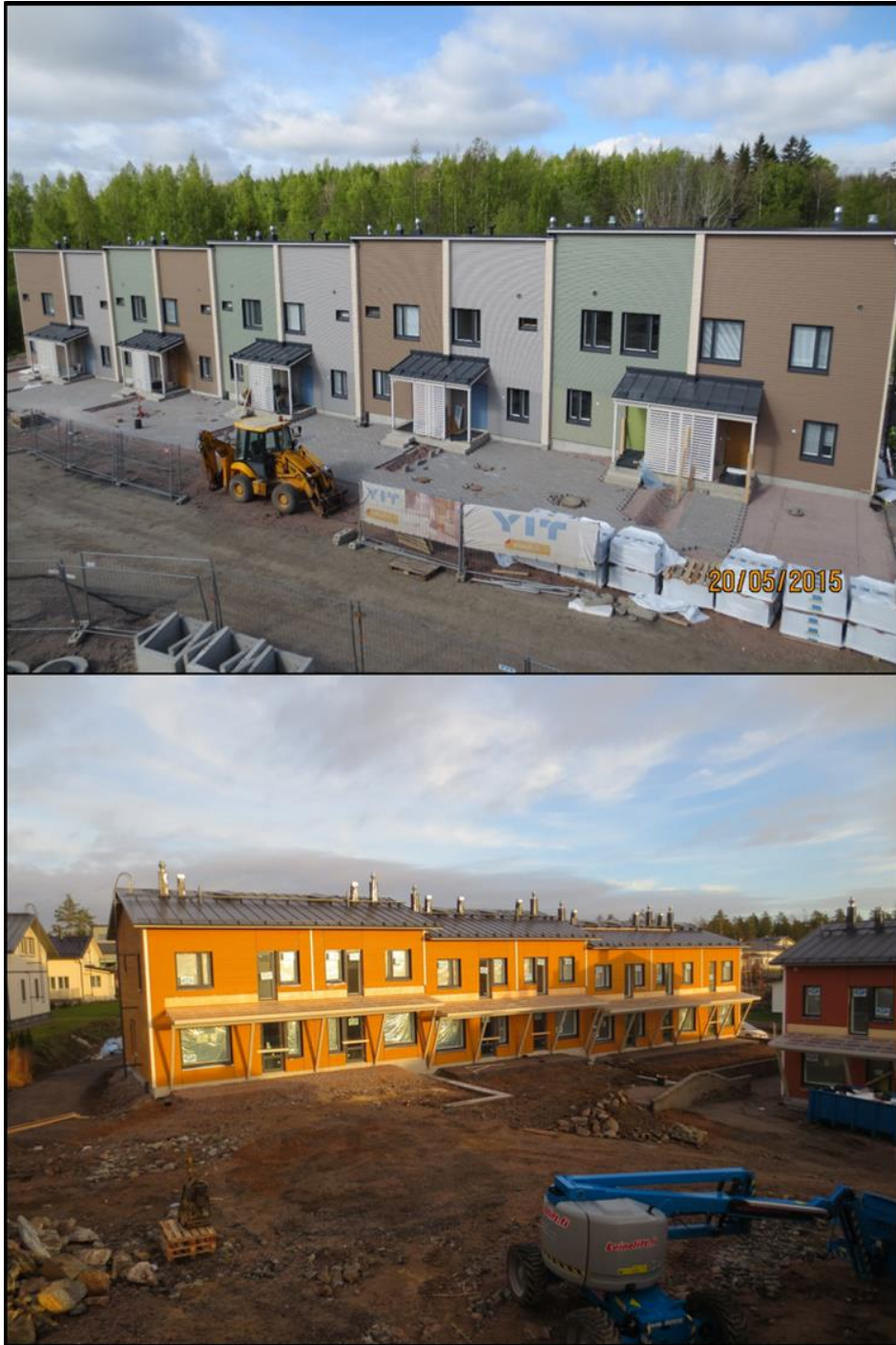
Kuva 2. Asuintalot Uusimaa -yksikön pientalotuotantoa. As Oy Vantaan Torppari ja As Oy Siipoon Laventeli kuvattuina rakentamisvaiheessa.
