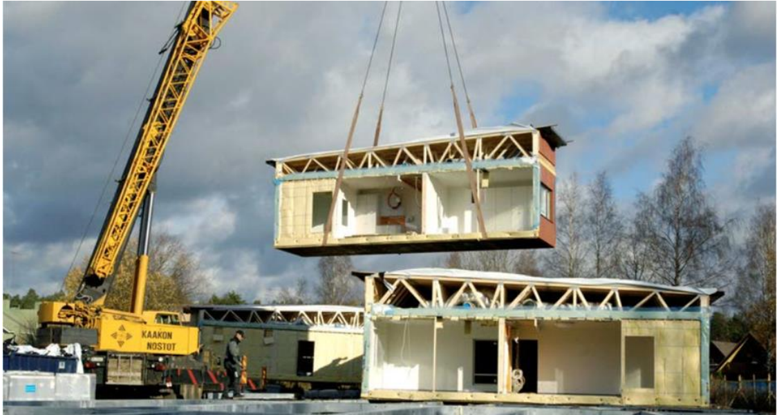
Kuva 22. Tilaelementit, joissa on valmiina lattia-, katto- ja seinärakenteet sekä sisä- ja ulkoverhoilu.
