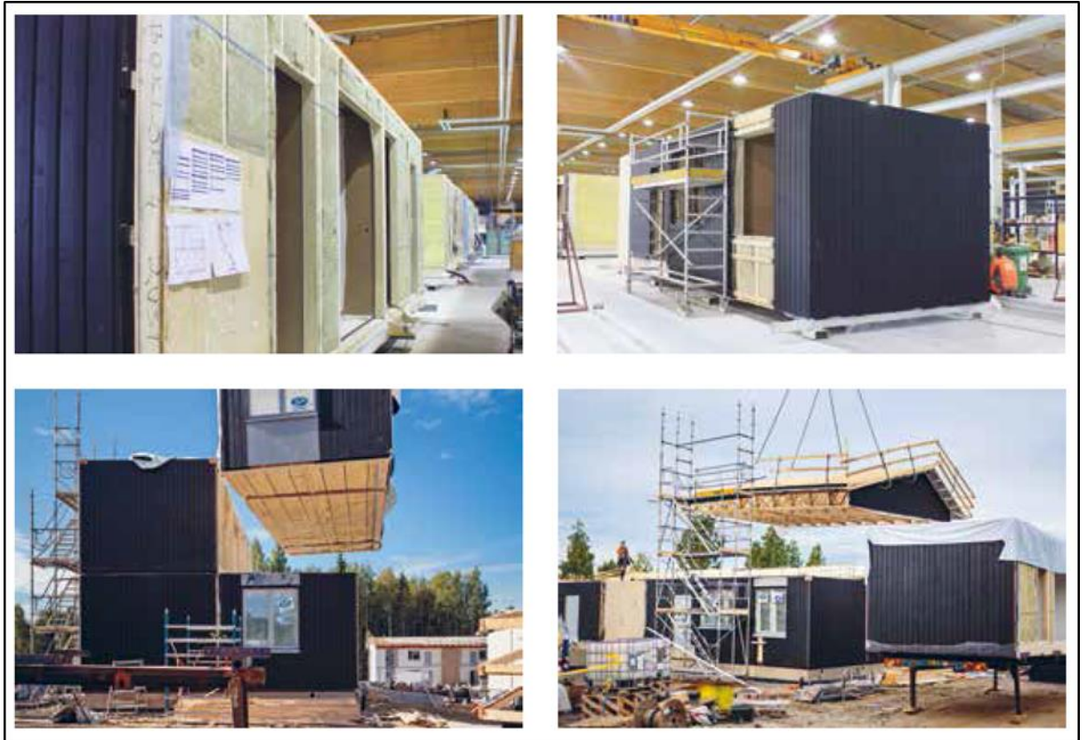
Kuva 24. Tilaelementit valmistetaan tehdashallissa ja asennetaan paikoilleen nosturilla.
