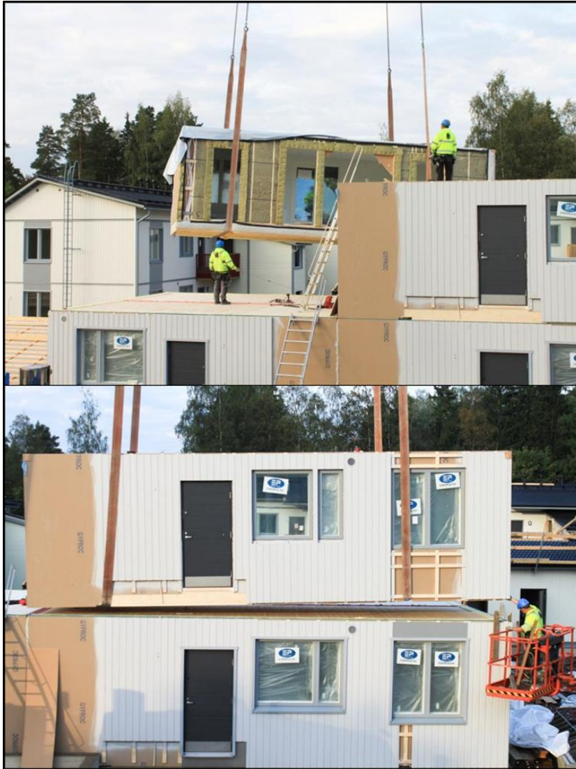
Kuva 25. Tilaelementtien asennus on parhaimmillaan hyvin nopeaa.
