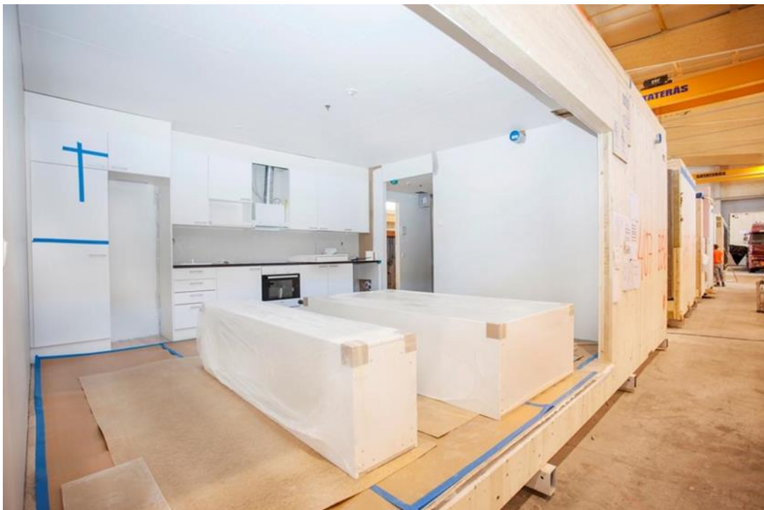
Kuva 23. Tilaelementti, johon on asennettu tehtaalla keittiökalusteet ja osa kodinkoneista.
