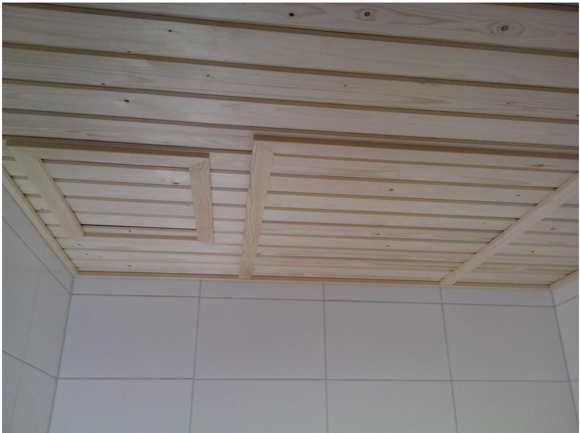
Kuva 4. Kylpyhuoneen paneloitu katto ja tarkastusluukut
