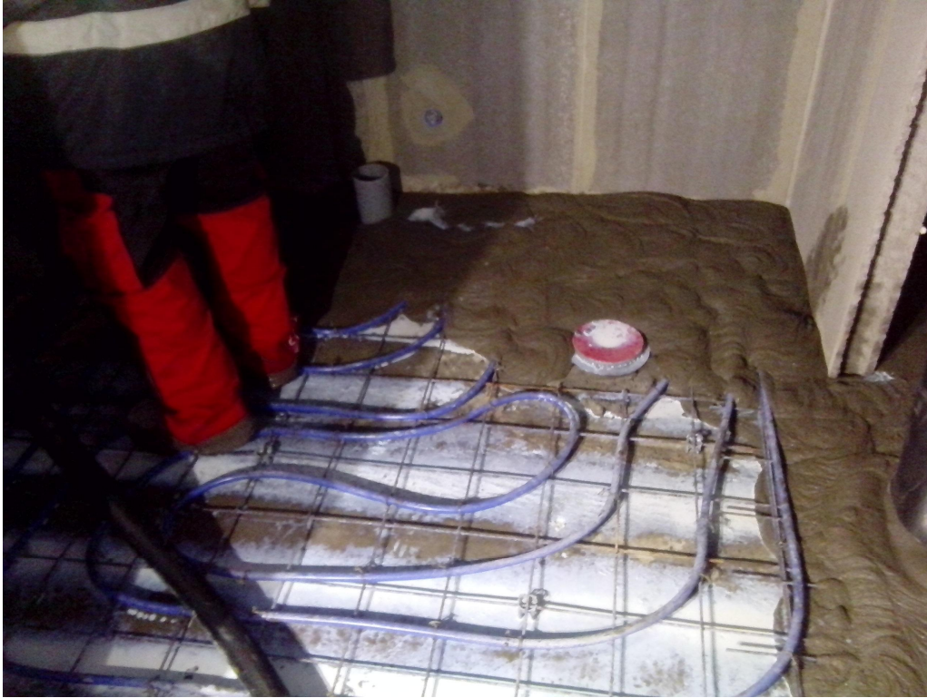
Kuva 3. Ontelolaatan päälle valettava pintabetonivalu käynnissä
