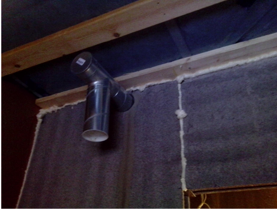
Kuva 2. Kylpyhuoneen ja löylyhuoneen välinen seinä
