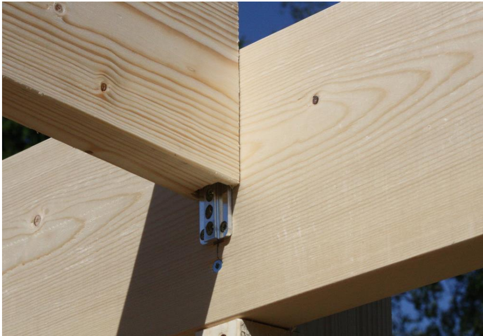
Kuva 12 Sherba kiinnikkeellä kiinnitetty palkki (Nieminen 2015)
