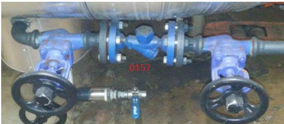
Kuva 17. Bosch-kattilan lauhteenpoistin 0157
