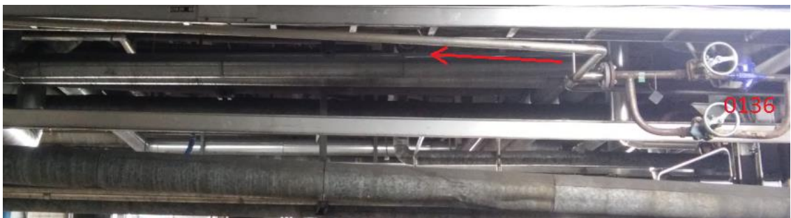
Kuva 13. Lauhteenkeruulinjan 1 kallistus ja putkiliitos
