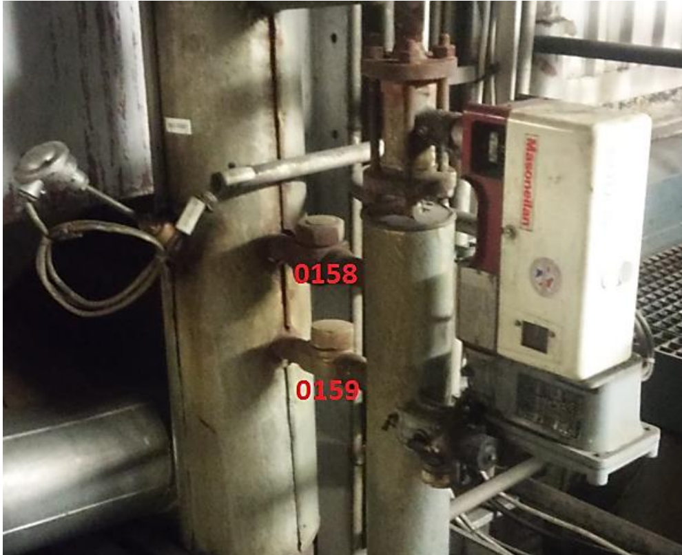
Kuva 20. Tampella-kattilan lauhteenpoistimet 0158 ja 0159 sekä venttiili 302-HC310
