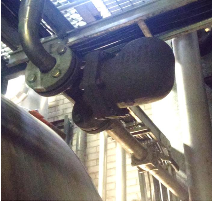
Kuva 18. Hönkälämmönvaihtimen lauhteenpoistin 0154
