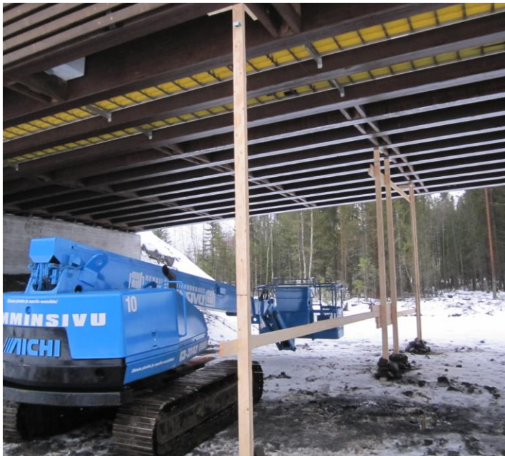
KUVA 17. Kertopuusta rakennettu teline, jonka varaan siirtymäanturit asennettiin.
