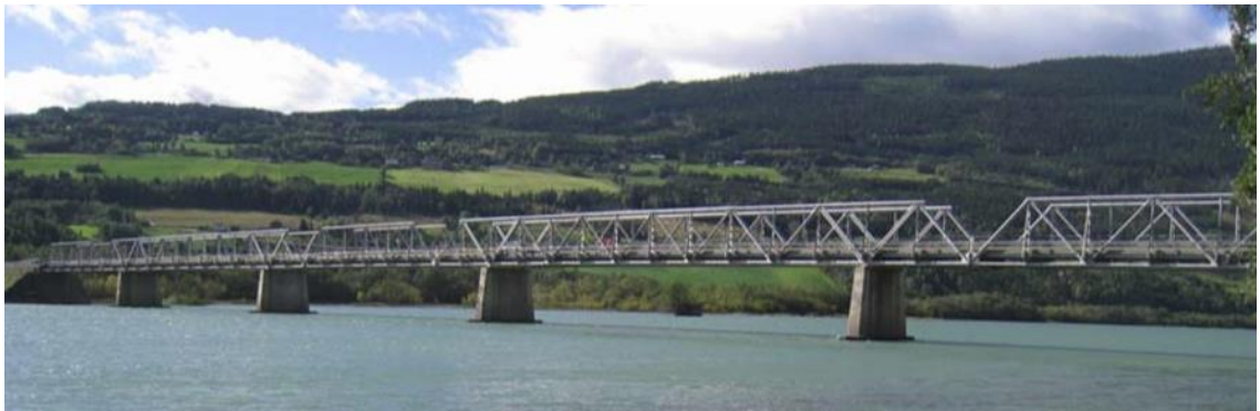
KUVA 55. Hundorp Bridge Norjassa (Abrahamsen & Nyløkken 2010, 372)
