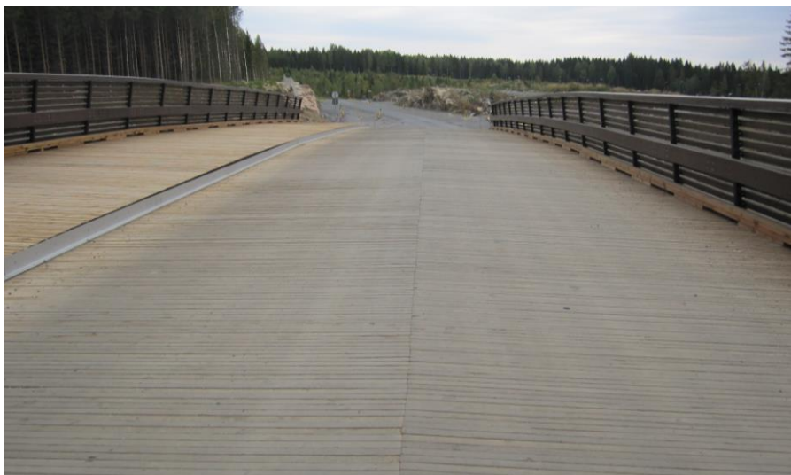
KUVA 12. Tervassillan syrjälankkukansi (Kuva: Heli Viljanen 2015)
