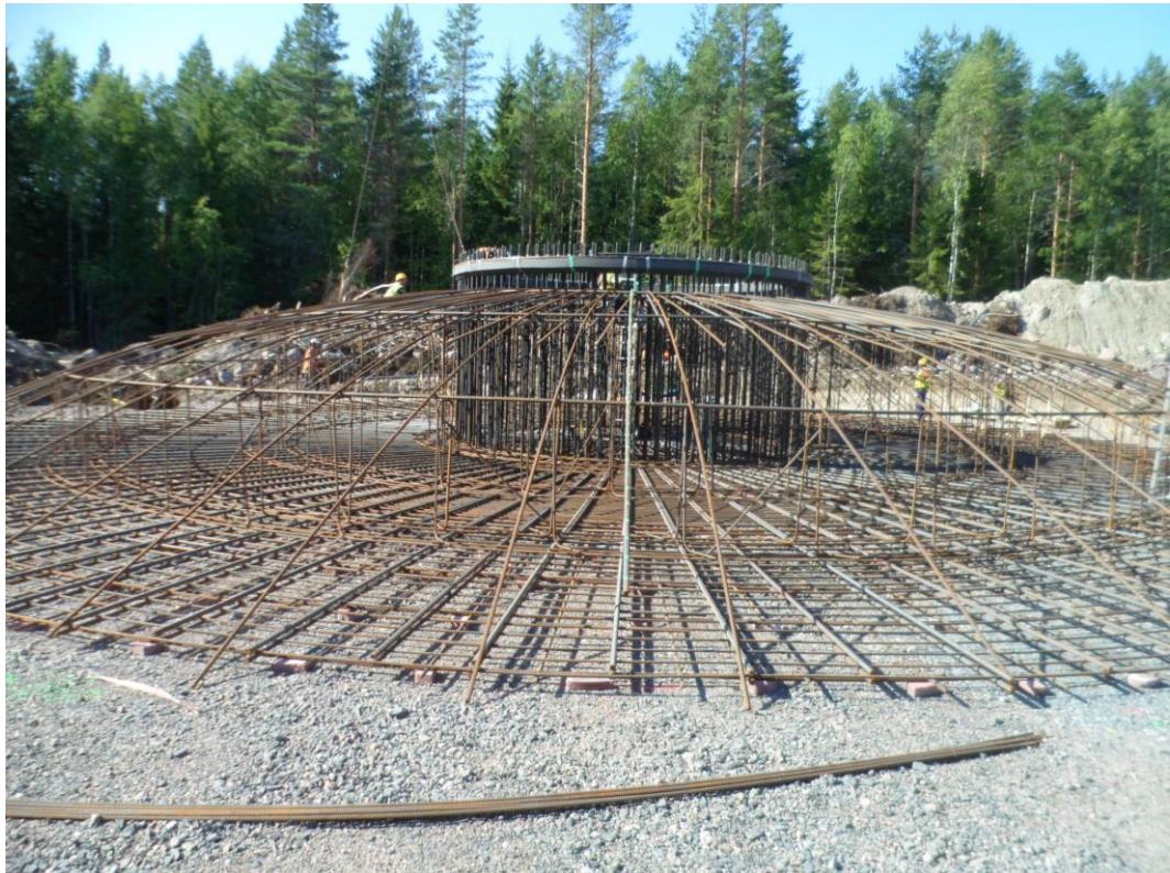
Kuva 9 Pulttikori jonka ympärille on alettu kasaamaan perustusten raudoitusta.
