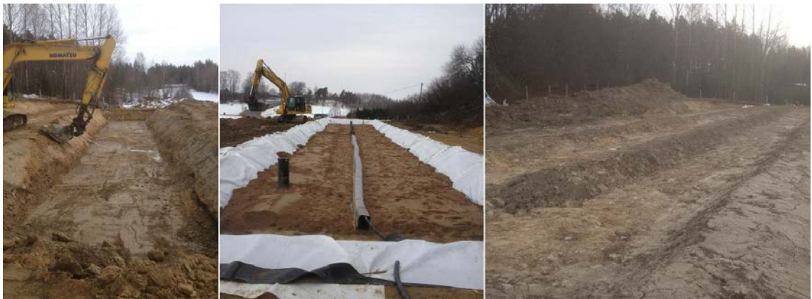
KUVA 7: Pajualtaan kaivuu, vuoraus ja täyttö (L&G Pajupuhdistamo Oy, 2013)
