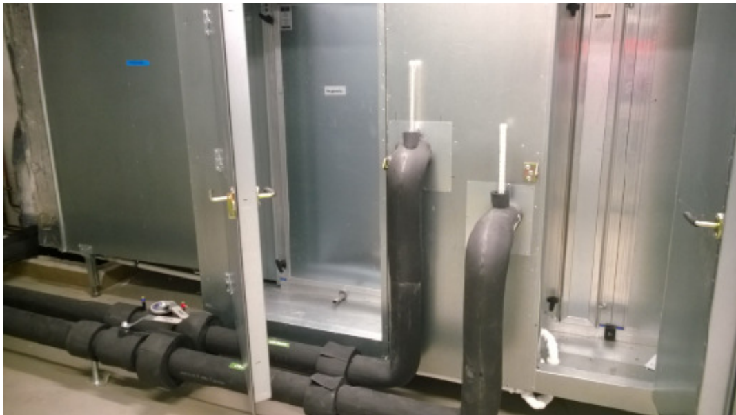
Kuva 26. Vesitysyhteet ja tippavesiviemärointi
