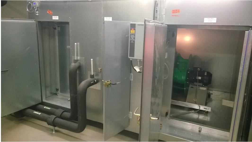
Kuva 25. Valmis kotelo huoltoluukut avattuina
