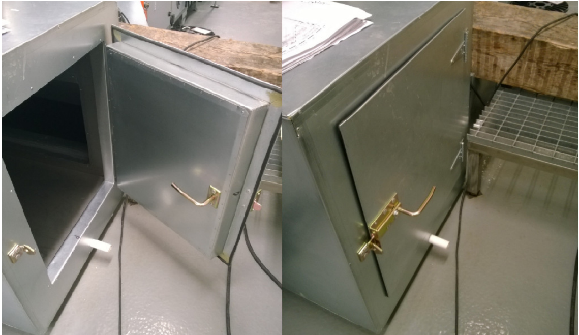
Kuva 15. Teetetty huolto-ovi raitisilmakammiossa
