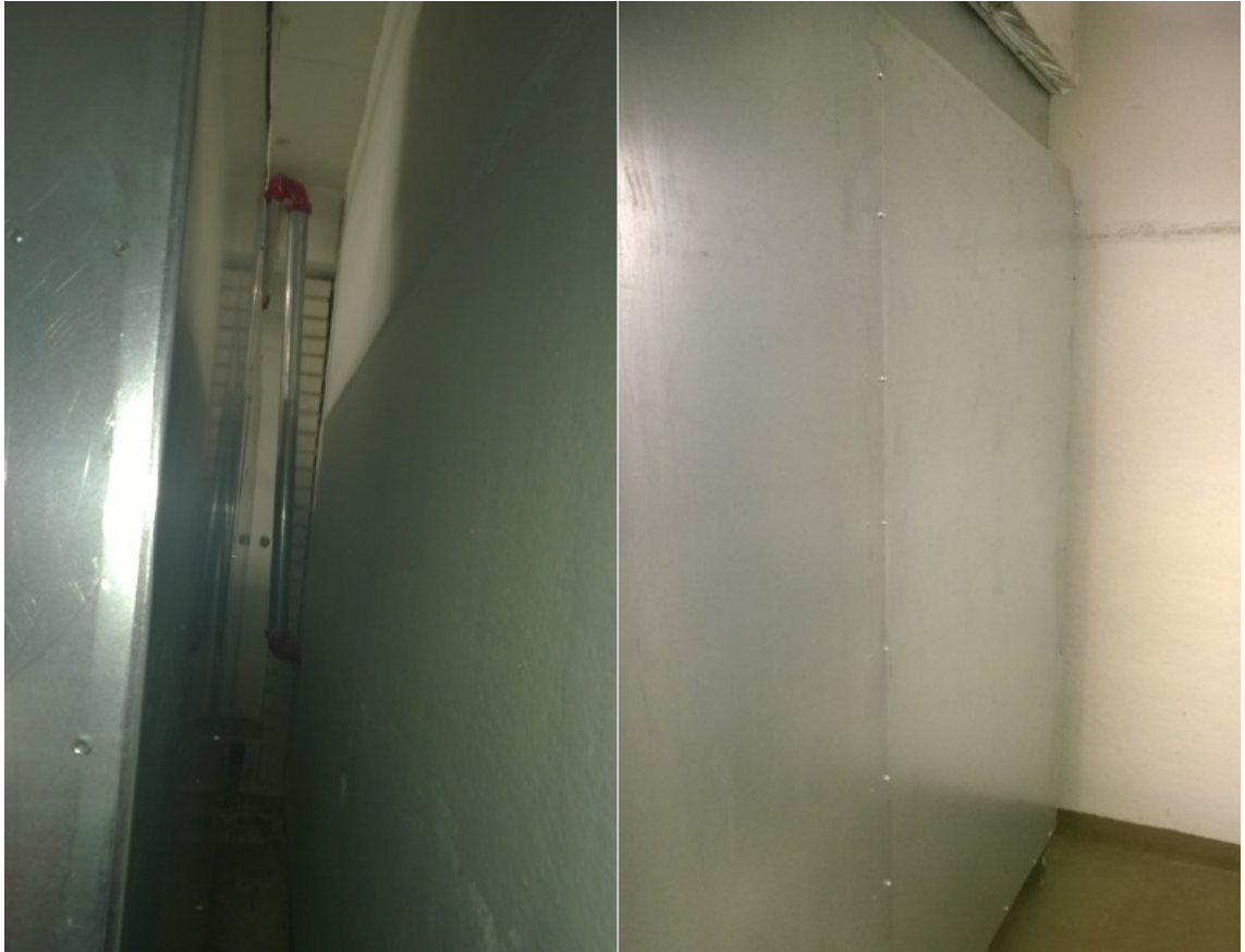
Kuva 19. Koteloinnin taka- ja sivuseinät
