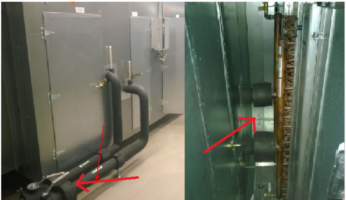
Kuva 17. LTO-patterin laippaliitokset kotelon ulko- ja sisäpuolella
