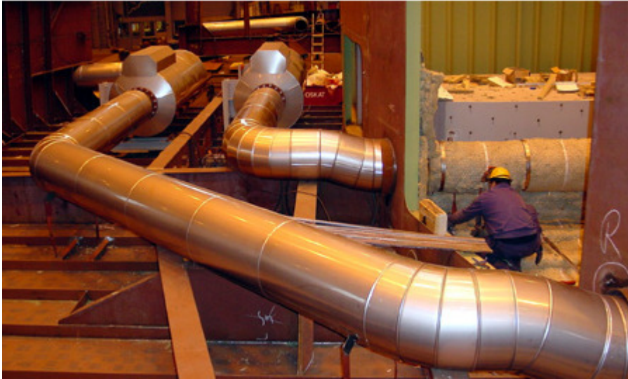
Kuva 3. Pellitettyjä ilmanvaihtokanavistoja [11]
