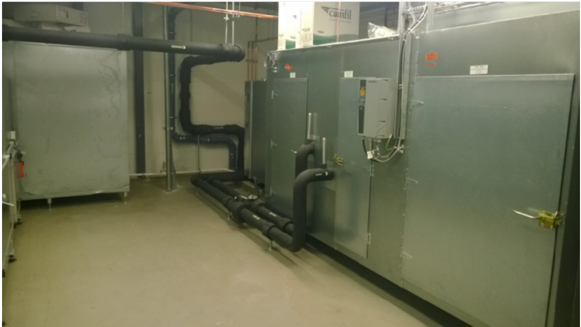
Kuva 23. Valmis kotelo huoltopuoleltaan
