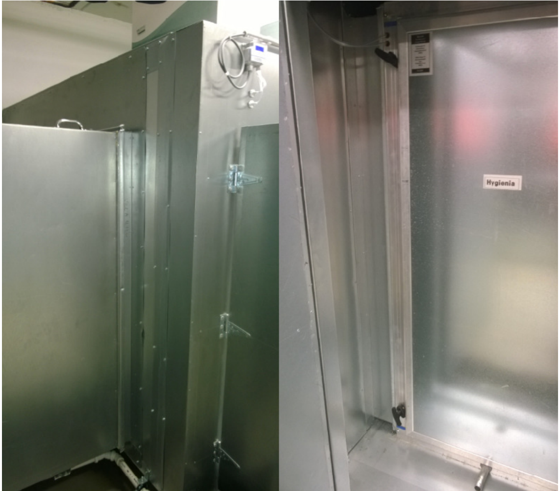
Kuva 14. Lamellivaimentimen ja IV-koneen liitos kotelorakenteen lävitse
