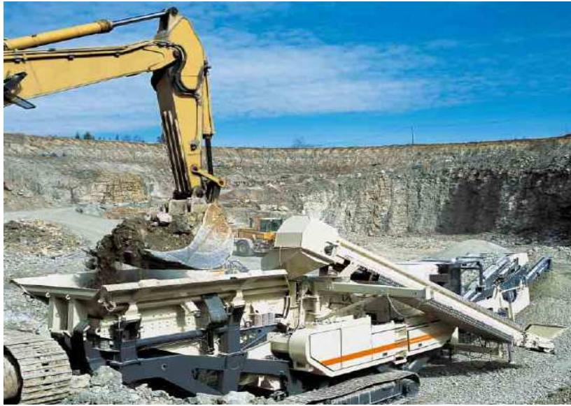
Kuva 12. Murskauslaitos, johon kaivinkone on syöttämässä kiviainesta [14.]
