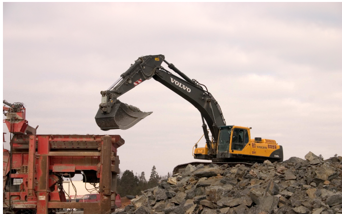
Kuva 7. Tela-alustainen kaivinkone soveltuu hyvin maa-ainesten siirtoon ja välppäämiseen [11.]
