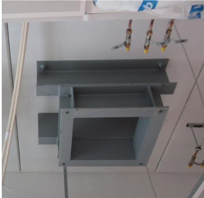
Kuva 7. Varrellisen kattokeskuksen kiinnityspukki asennettuna kattoon Jorvin työmaalla.
