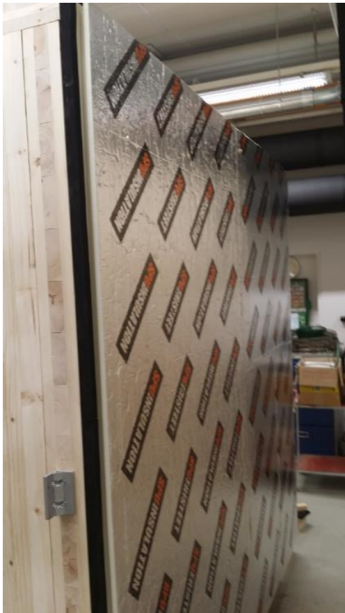
Kuva 18. SPU-levyt asennettuna elementin seinään.
