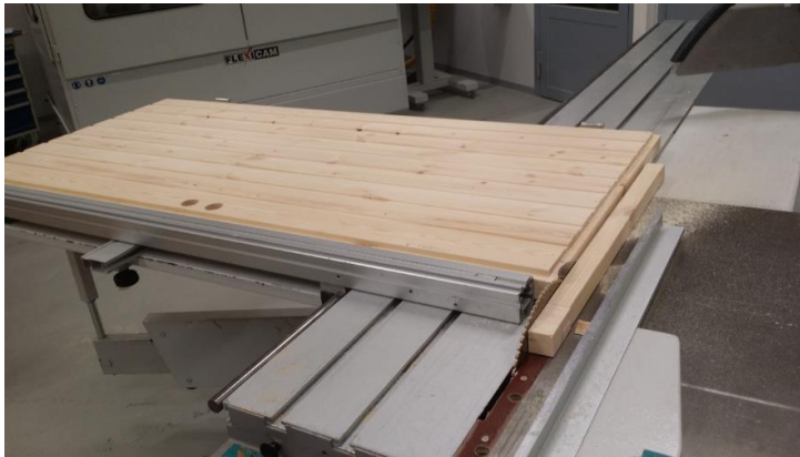
Kuva 3. Ovia lyhennettiin n. 5cm.
