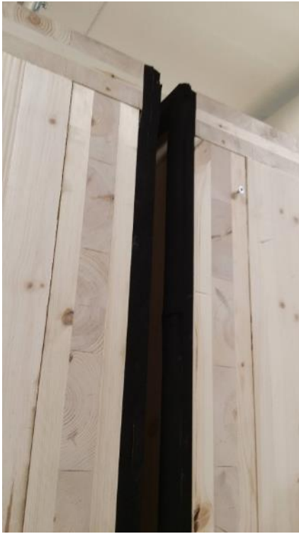
Kuva 7. Elementtien sivuseiniin liimattiin solumuovikaistat.
