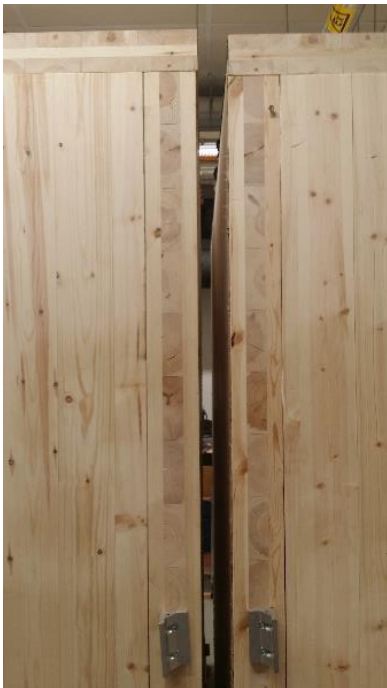
Kuva 26. 50 mm ilmarako ilman solumuovikaistaa.
