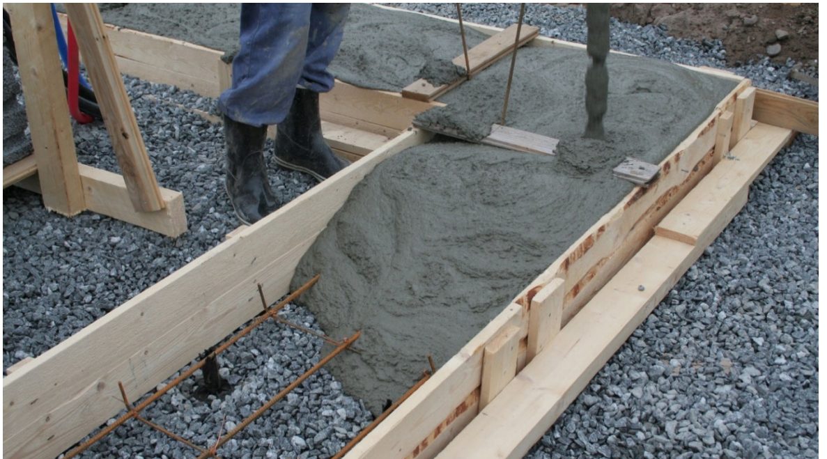
Kuva 2. Anturan betonointi (Rakentaja.fi, 2015)
