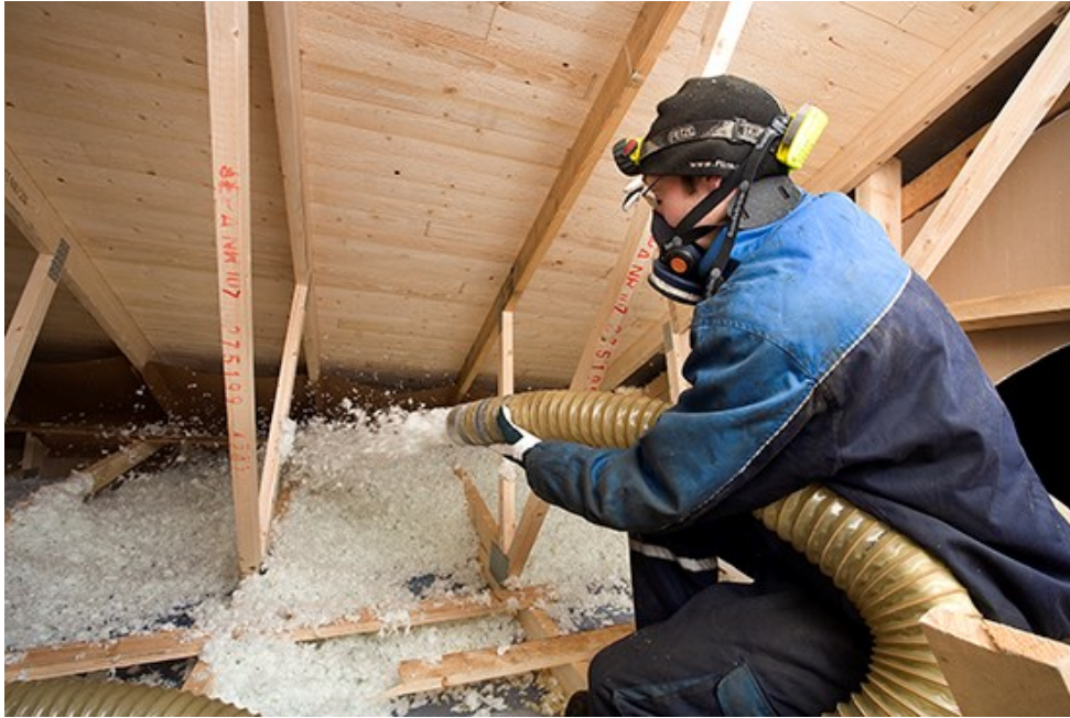
Kuva 5. Puhallusvillan asennus (Isover.fi b)
