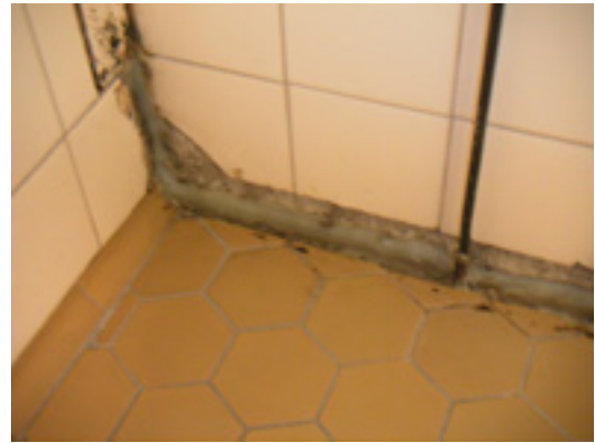
Kuva 12. Kuorimon huoltolan suihkunurkkauksen lattian ja seinän liitos
