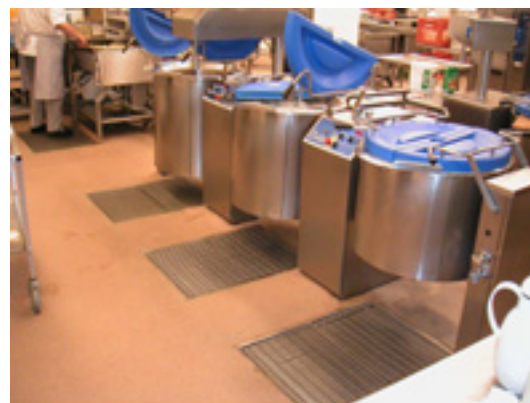
Kuva 25. Yleisnäkymä ruoan valmistustilasta
