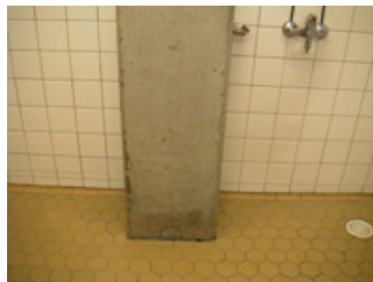
Kuva 15. Huoltola 1:n suihkun vieressä oleva pilari
