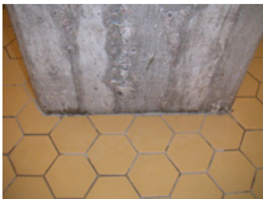
Kuva 14. Pilarin ja lattian sauma
