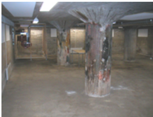
Kuva 23. Yleisnäkymä paloaseman väestönsuojasta
