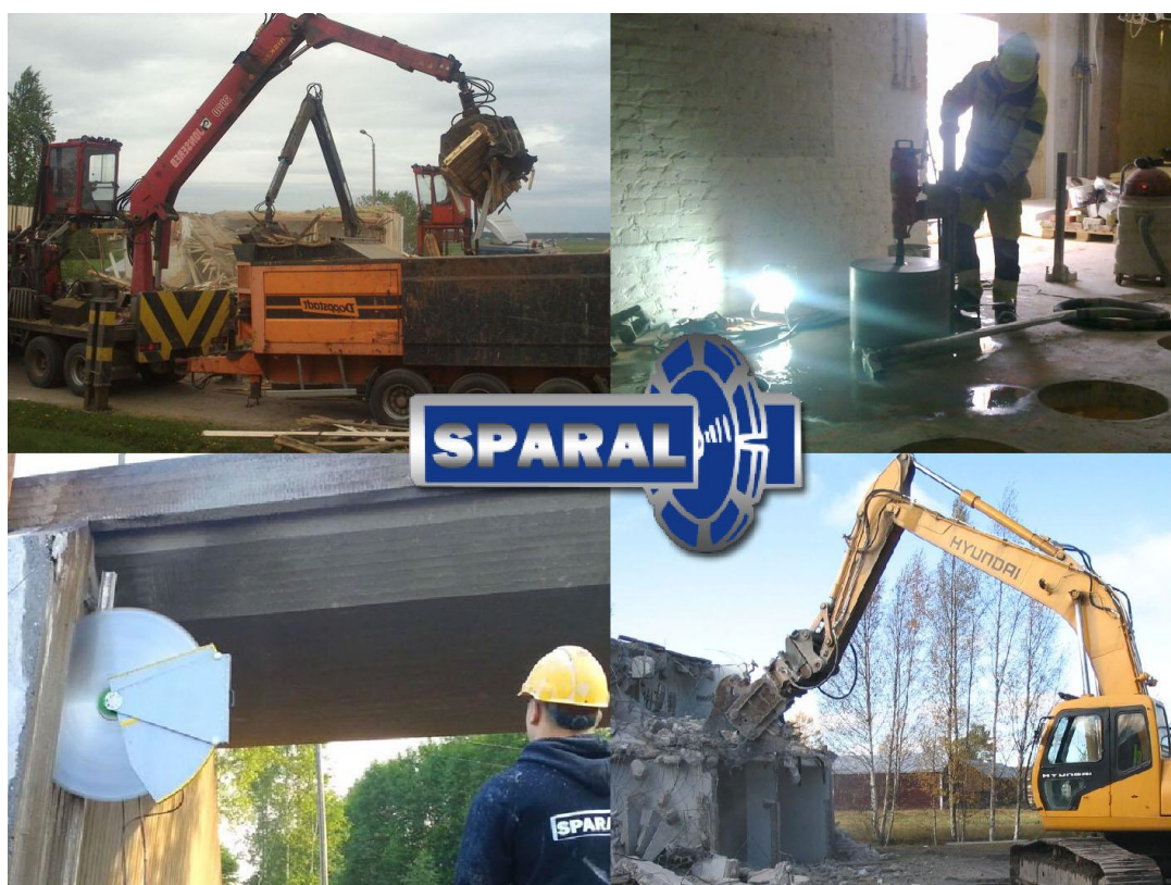
Figur 1: Exempel på rivningsarbeten.
