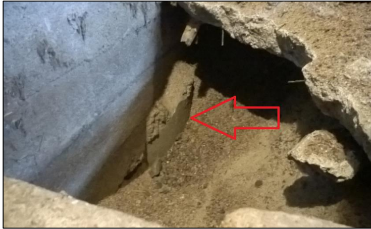
KUVA 2.4 Heinähuoneen rakenneavaus ja paalun pää (Kuva: Antti Naukkarinen 2016, muokattu)
