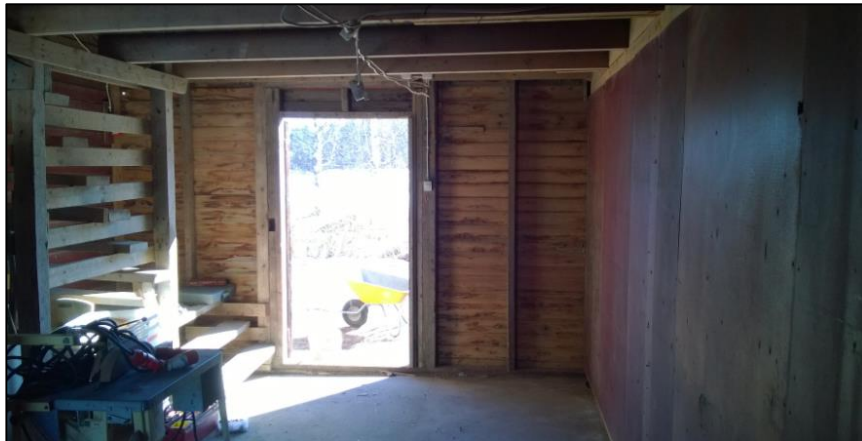
KUVA 4.13 Varasto kevyiden väliseinien purkamisen jälkeen
