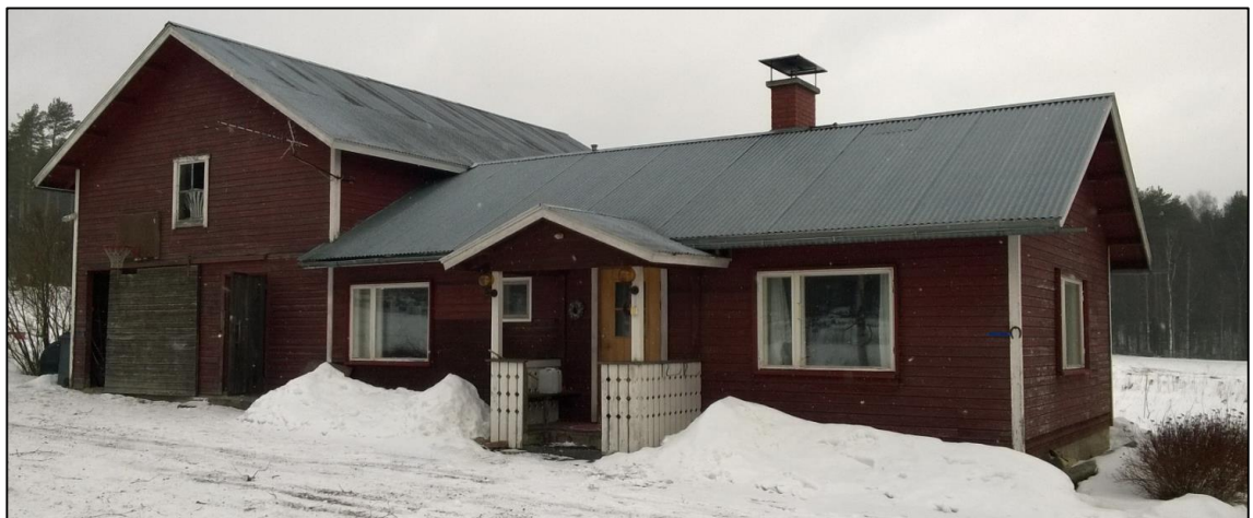
KUVA 2.1. Muutostyön kohde (Kuva: Antti Naukkarinen 2016)
