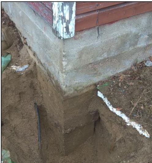
KUVA 4.15 Rakennuksen vanhimman osan perustus (Kuva: Antti Naukkarinen 2016)
