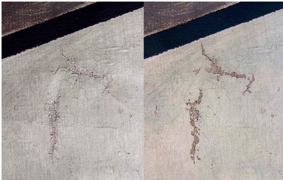
KUVA 22. Vaurioalue ennen ja jälkeen maalinkiinnityksen.
