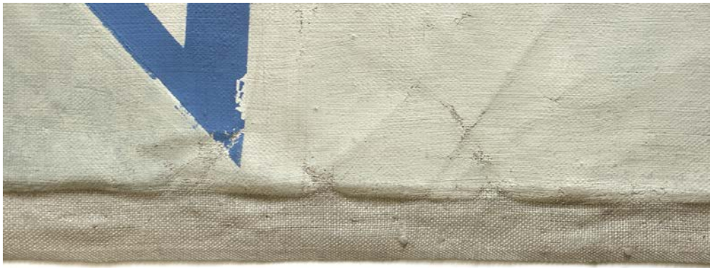
KUVA 9. Kiilakehyksen ulkokantin aiheuttama kohouma. Taitereunat ovat maalaamattomat.
