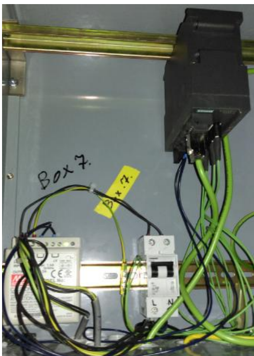
Kuvio 21. Automaattisulake asennettuna virtalähteen syötön eteen sekä kytkin.
