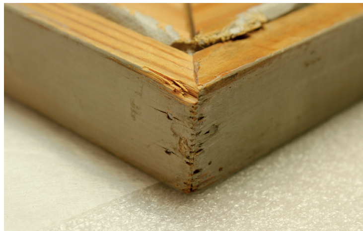
Kuva 30. Kehyksen kulman vaurio.
