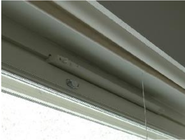
Kuva 3. Ikkunan yläkarmiin asennettu rakoventtiili. (Rakennusperintö)
