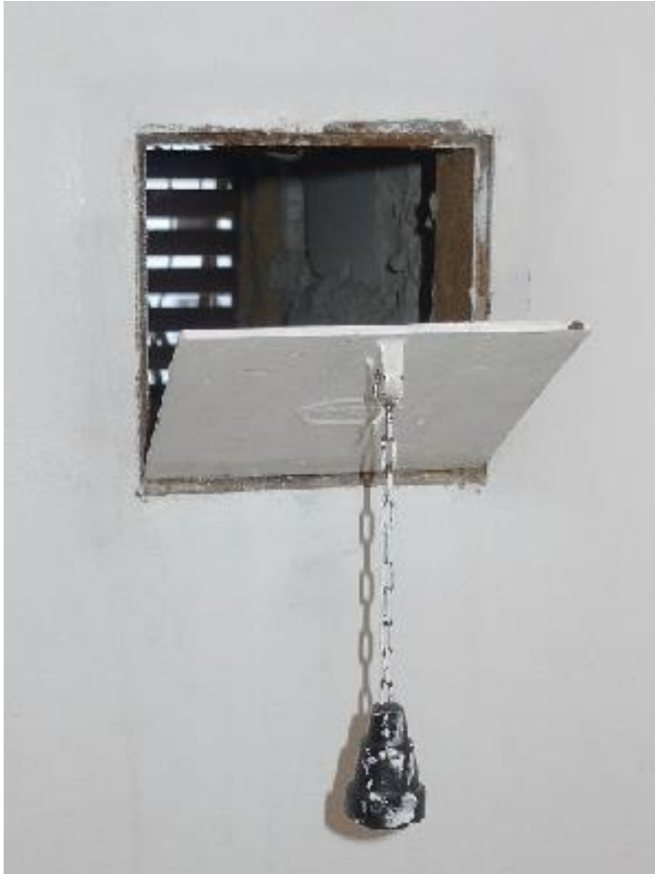
Kuva 2. Vanha korvausilmakanava asunnosta kuvattuna. (Rakennusperintö)
