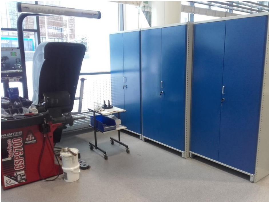
Kuvio 15. Rengastyötilan kaapit asennettuna seinäksi.
