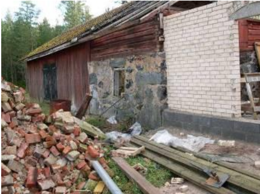
Kuva 1. Saunatupa alkutekijöissään kesällä 2008
