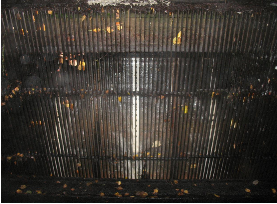
Kuva 31. Rekolan vesivoimalaitoksen välppä (UPM Kymmene)
