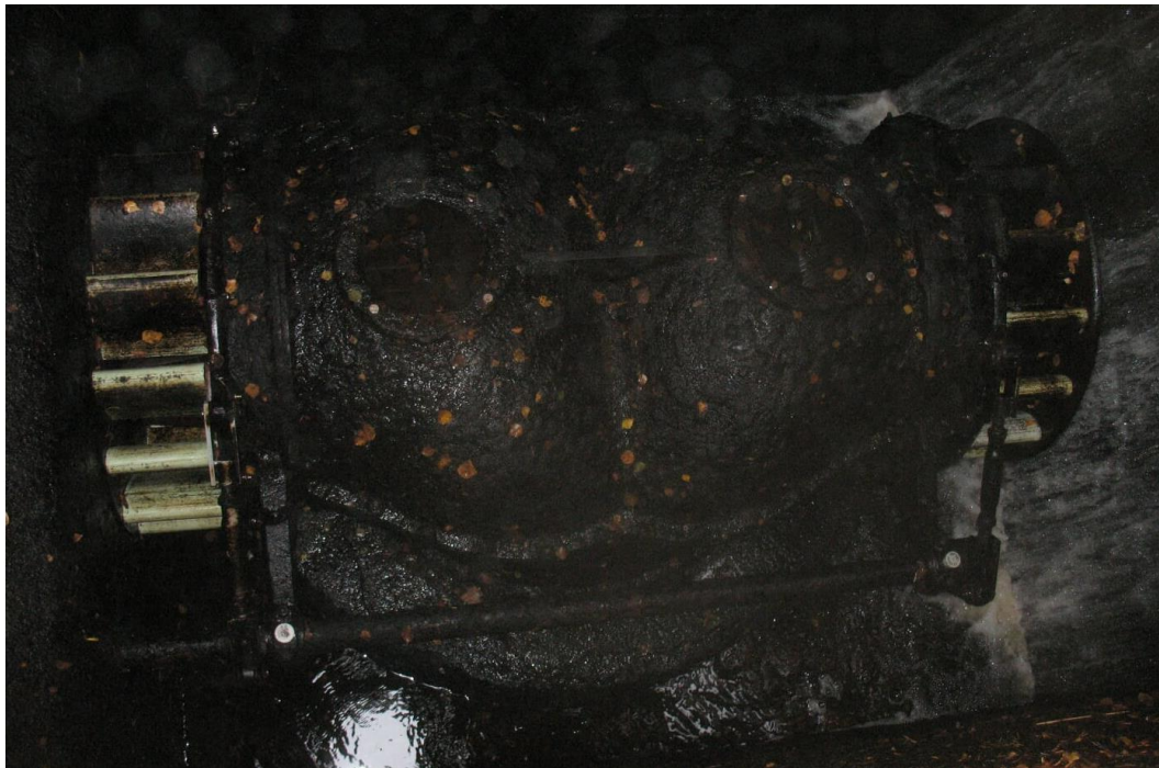
Kuva 28. Rekolan vesivoimalaitoksen turpiinikammio (UPM Kymmene)
