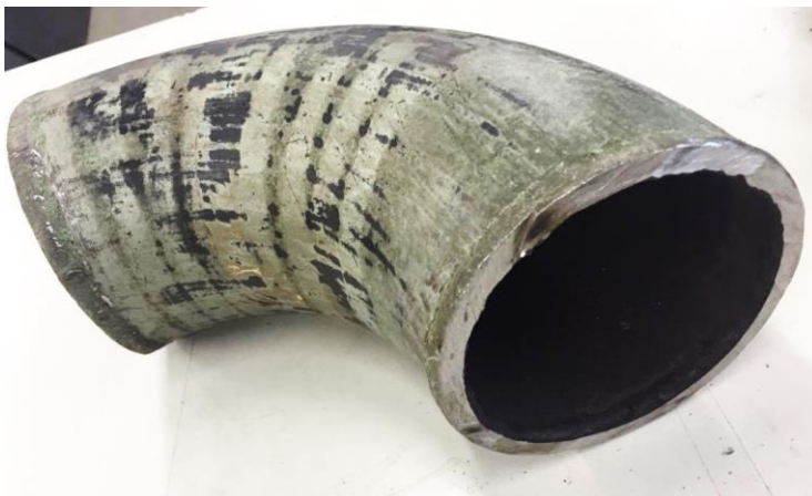
Kuva 10. Putki 1 ennen osiin sahaamista.
