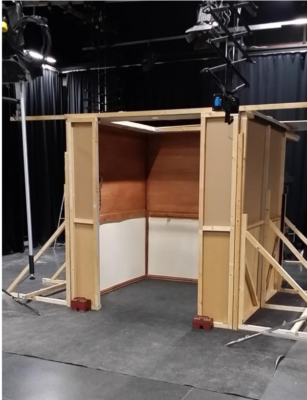
Kuva 1. Meduusa-studiolle rakennettu hissi
