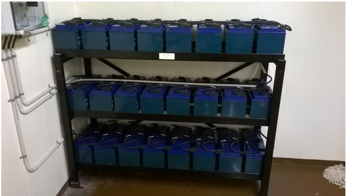
Kuva 9. UPS-laitteen akusto, 48 kpl Caldwell HF21-211W 45Ah/12V:
