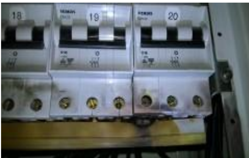
Kuva 2. Keskuksessa palaneita johdonsuojakatkaisijoita
