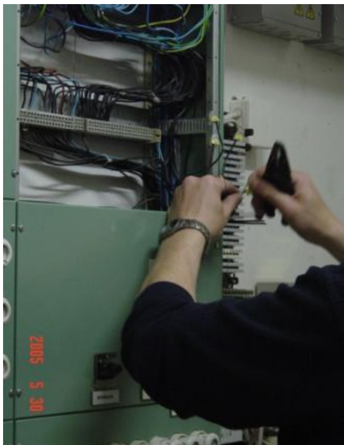
Kuva 1. Keskuksessa havaittujen irrallisten johtimien päättäminen sähköalan ammattihenkilön toimesta
