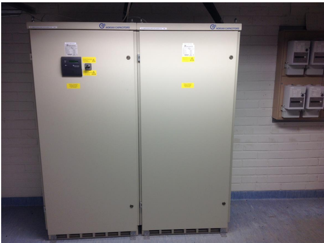
Kuva 6. Loistehon kompensointiin käytettäviä Nokian Capacitors Ltd:n (nykyään Alstom Grid Oy) valmistamia laitteistoja
