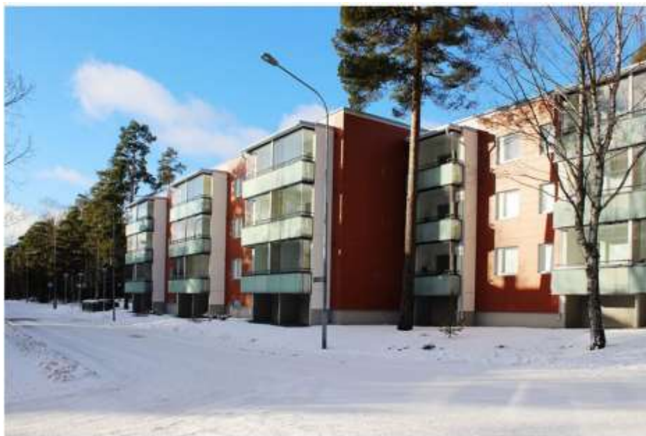
Kuva 12. Työmaakohde. (TVT-asunnot, Pansio/Perno Turku)
