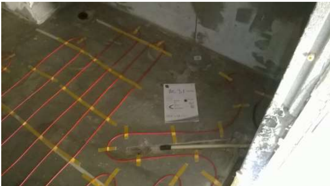
Kuva 12. Lattialämmityskaapeli. (Jaakko Salminen, työmaakuva, 2015)
