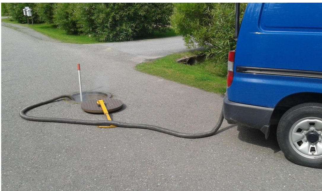
Kuva 11. Savunohjausletku asetettuna tarkastuskaivoon.
