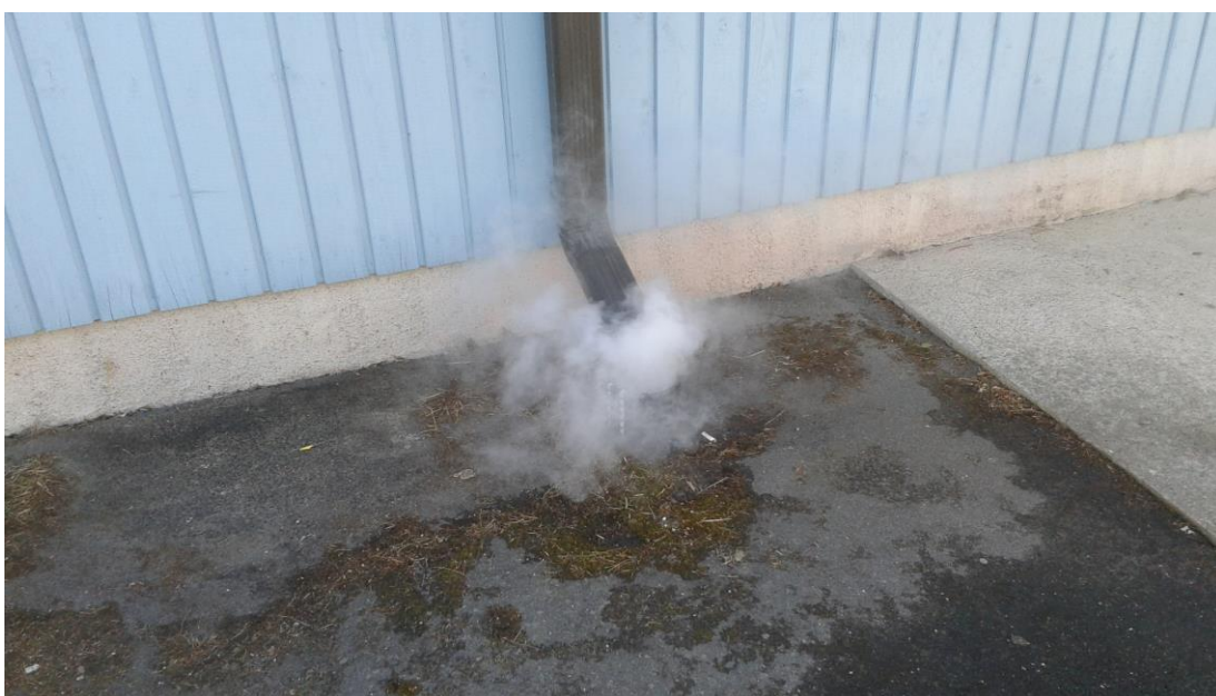
Kuva 13. Savu purkautuu rännikaivosta.
