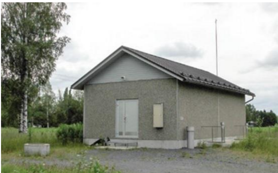
Kuva 3. Saaren pumppaamo (Uvilan vesilaitoksen esite 2014)
