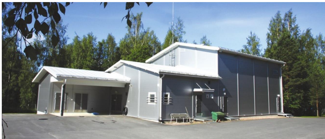
Kuva 2. Ulvilan vesilaitos (Ulvilan vesilaitoksen esite 2014)
