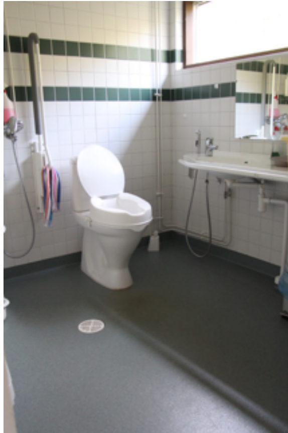
Kuva 12. Epäkäytännöllinen wc vaikeuttaa huomattavasti työntekijöiden työtä.
