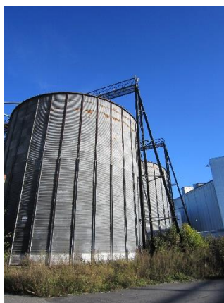
Kuva 9. Vanhoja lentotuhkan varastointiin soveltuvia säiliöitä.
