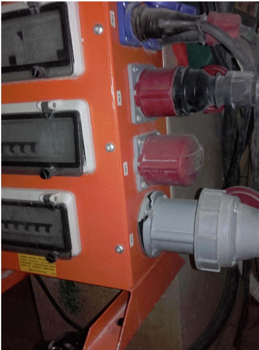
Kuva 7. Keskuksen lähtö on melkein kokonaan rikki.
