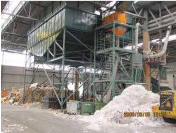
KUVA7. Paalikone ja sen ympäristö (AMH-SYSTEMS OY.)
