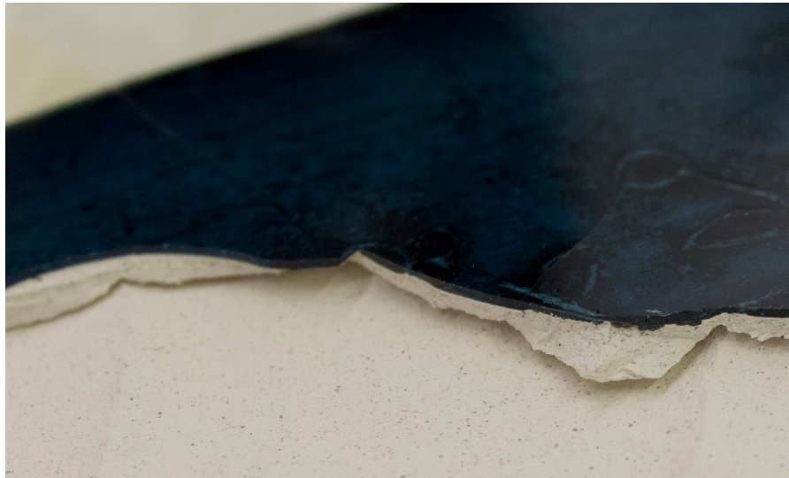
Kuva 12. Deformoituneen alueen reuna ennen rakenteen vahvistamista lasipalloseoksella.
