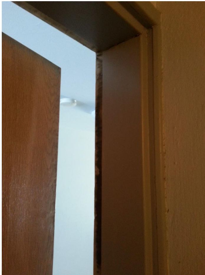
KUVA 11. Rappukäytävästä vuotaa likaista ilmaa yleisiin tiloihin
