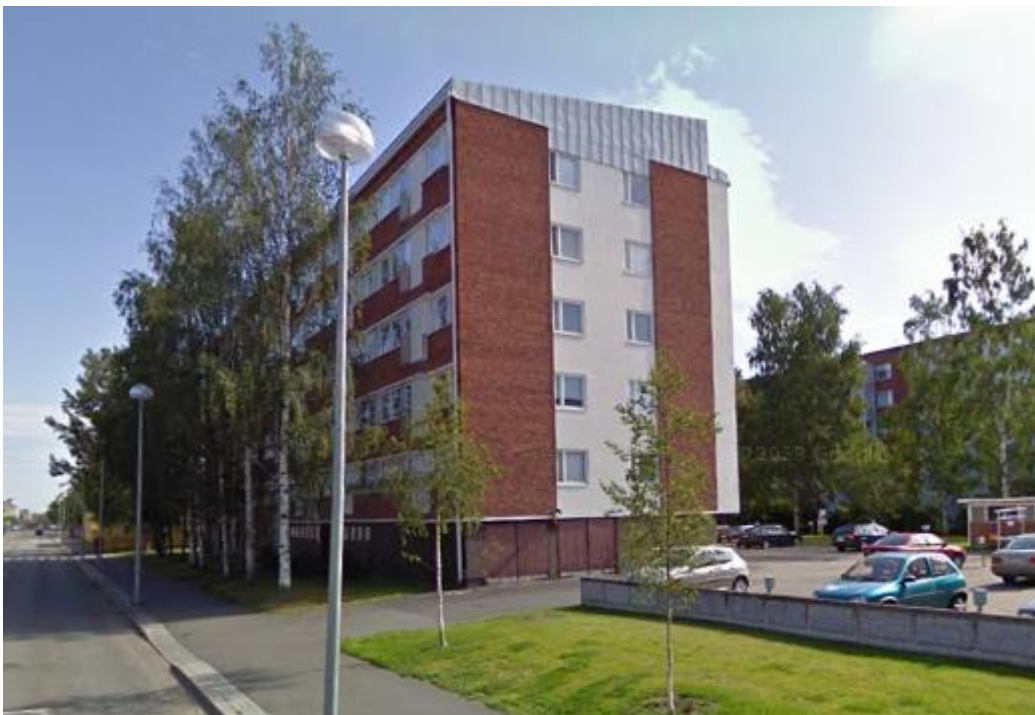
KUVA 3. Rakennuksen julkisivukuva, josta selviää rakennuksen katon muoto ja julkisivuissa käytetyt materiaalit
