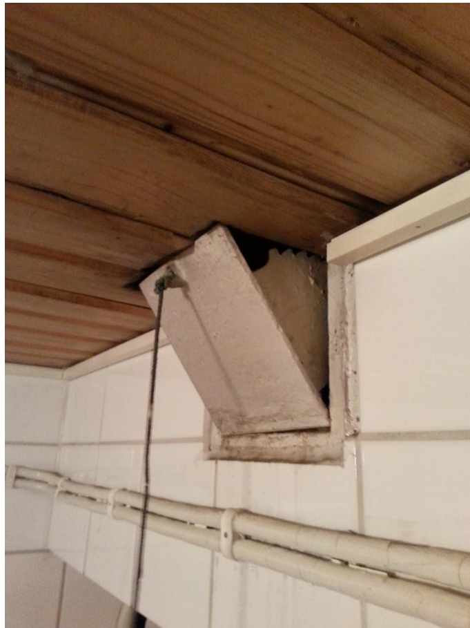
KUVA 14. Saunan poistoilmaventtiili
