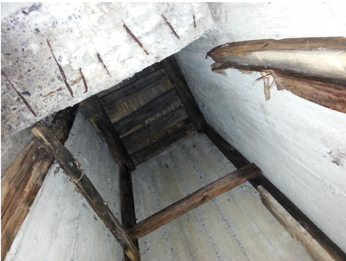
KUVA 17. Roskakuilun lahonneet puurakenteet
