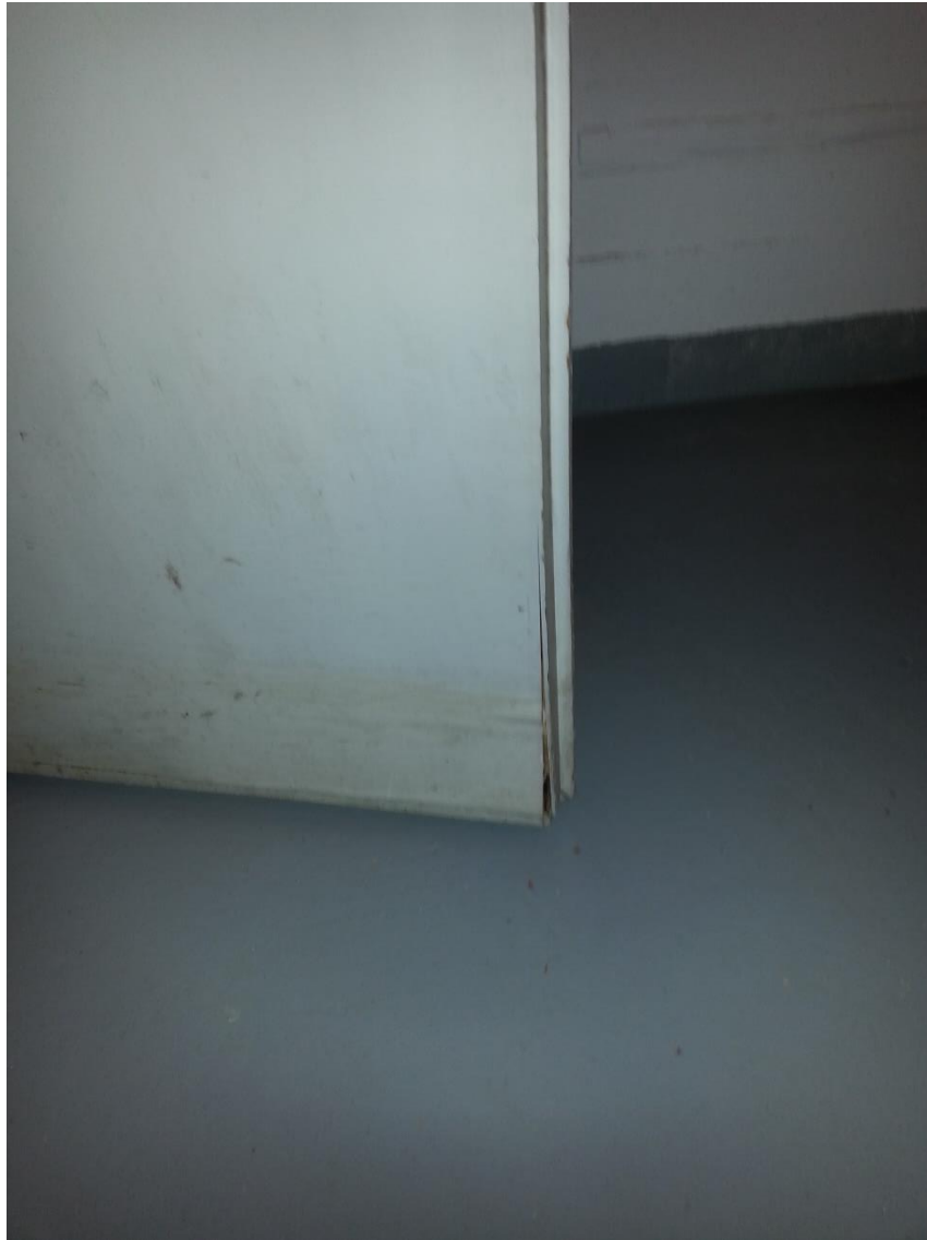
KUVA 20. Väestönsuojan turvonnut väliovi
