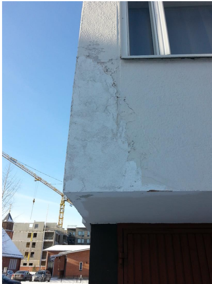
KUVA 7. Korjattu rappauspinta lohkeilee irti alustastaan
