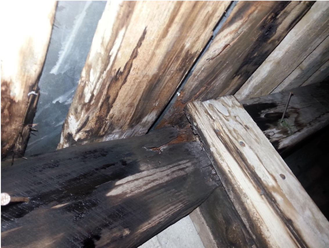
KUVA 26. Lahonnut kattoristikko
