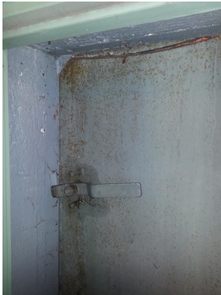
KUVA 18. Väestönsuojaan johtava ulko-ovi
