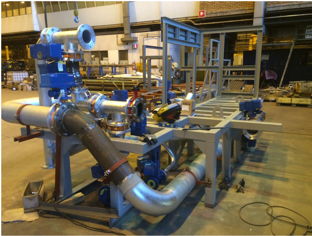
Kuva 16. Asennettuja putkia ja venttiilejä K01-A12 [Juha Järvinen].
