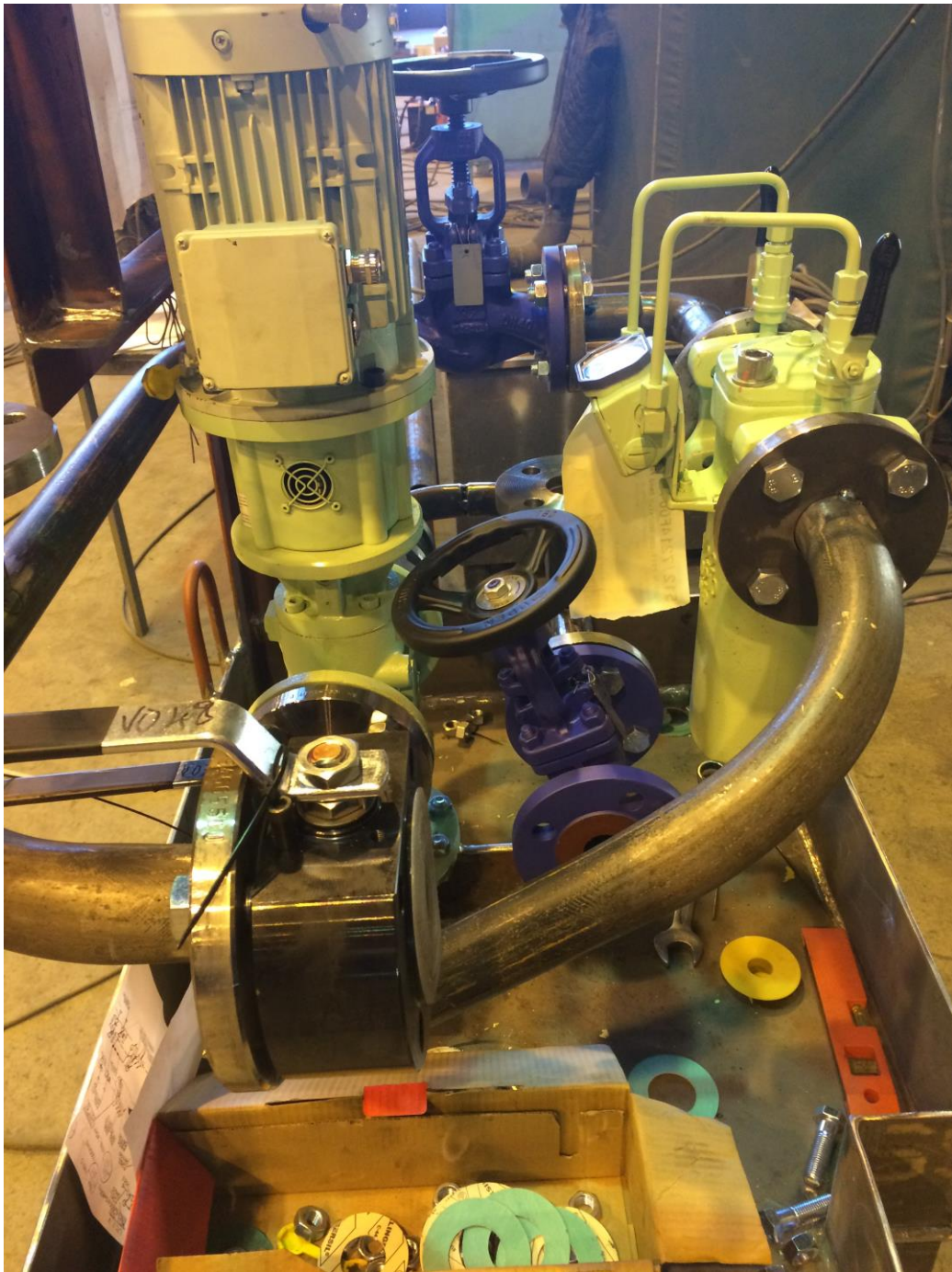
Kuva 19. Edessä vasemmalla kallistettu sininen venttiili ja oikealla käännetty vihreä suodatin [Juha Järvinen].
