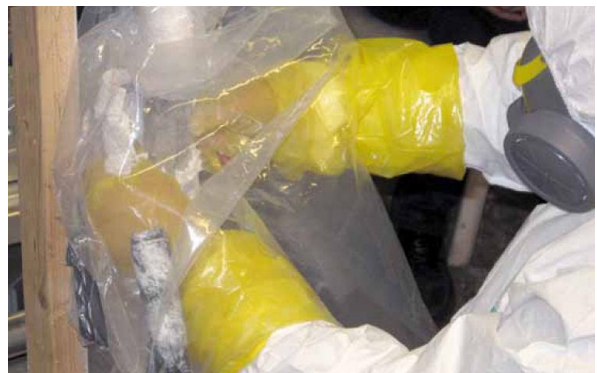
Kuvat 9. ja 10. Purkupussimenetelmän työvaiheet (Turun aikuiskoulutuskeskus 2016).
