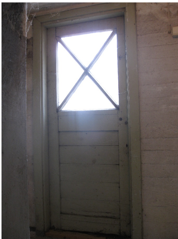
Kuva 9. Toinen pohjakerrokseen päätyovista (Liimatainen 2015).
