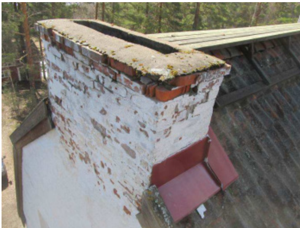
Kuva 11. Ulkoseinään integroidun savupiipun yläosa. (Janhunen T. Ahtonen S. Kettunen P. ja Kaasinen K. 2012, 41.)
