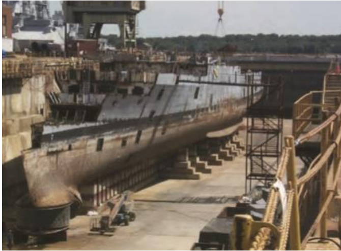
Kuva 7. Laivan romutusta kuivatelakassa. (OSHA 2010.)
