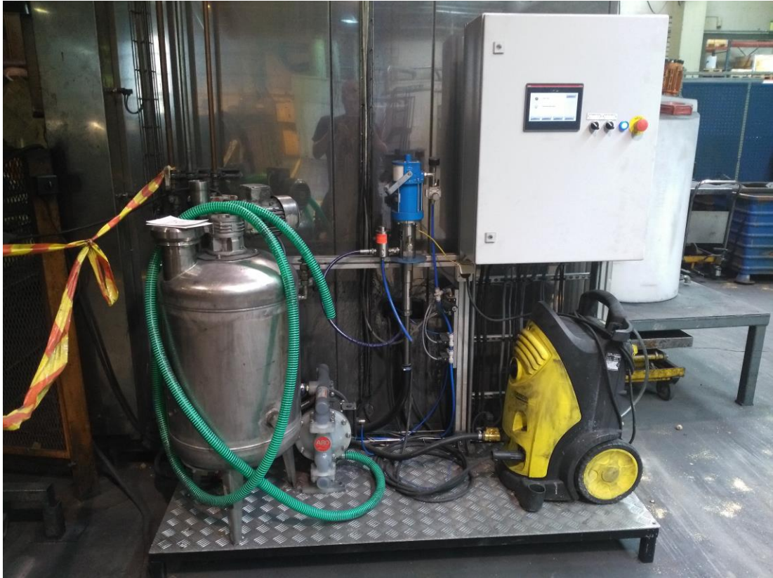
Kuva 6. Peitostusaseman laitteet ja uusi asennusalusta.
