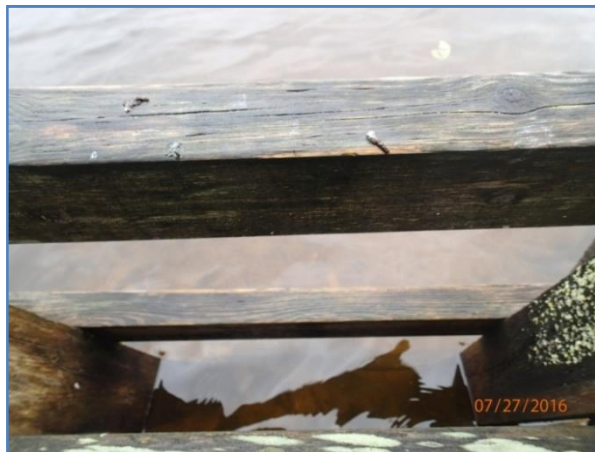
Kuvio 39. Huttujärven laituri, josta puuttuu yksi puola.
