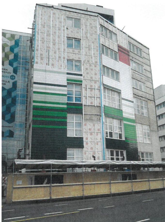
Kuva 5. Tykistökadulta vuokrattiin osa katualueesta työmaan käyttöön.
