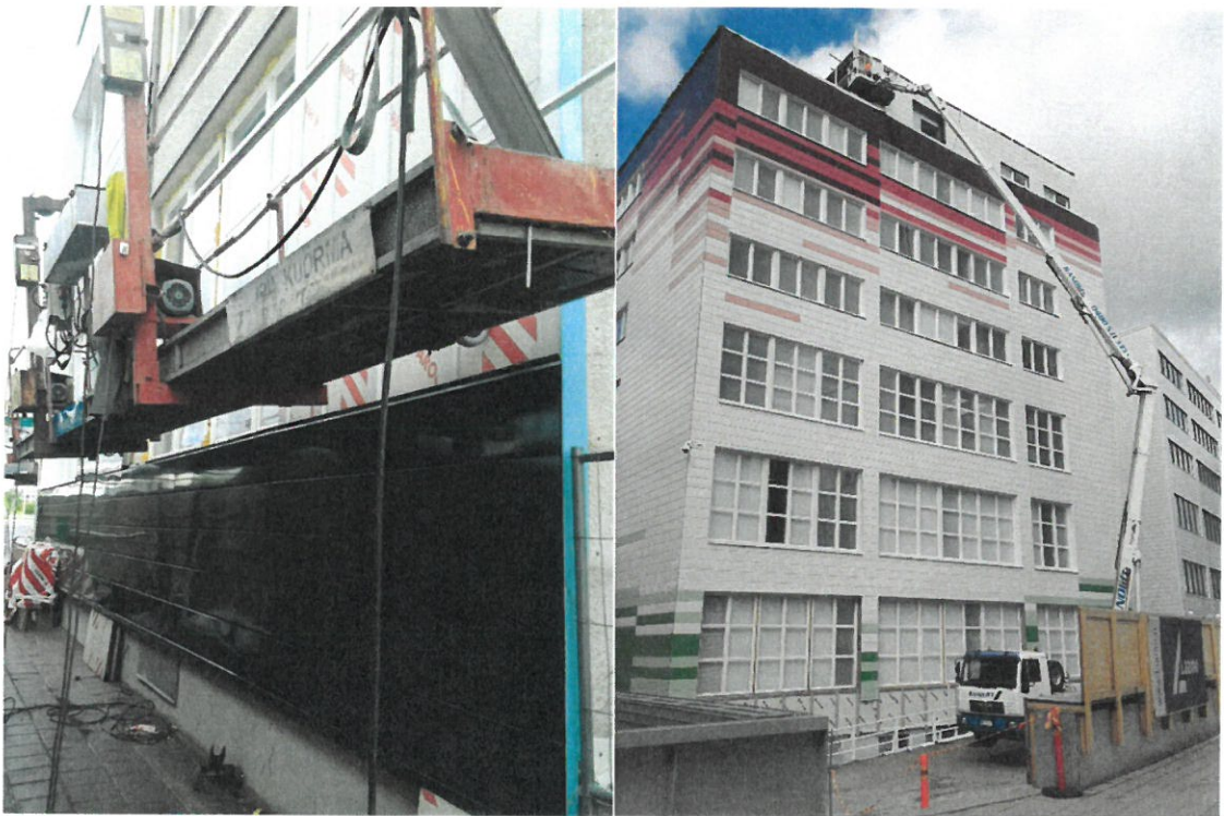
Kuva 2. Julkisivutyö tehtiin pääosin työkelkkojen avulla.
