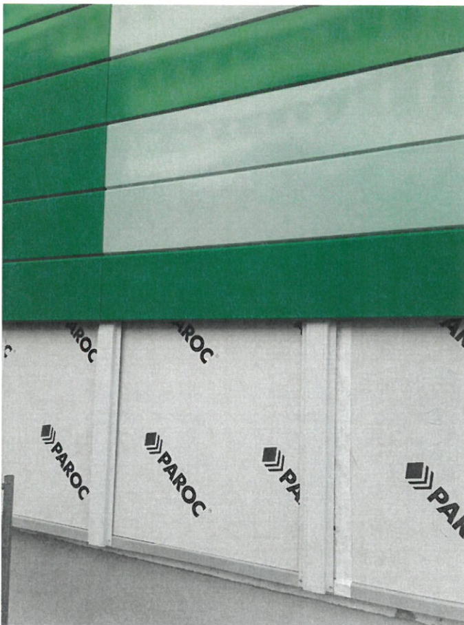
Kuva 6. Lisälämmöneristyksen sauman teippaus.
