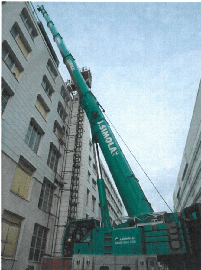
Kuva 3. Autonosturi nostaa tavaraa vesikatolle.
