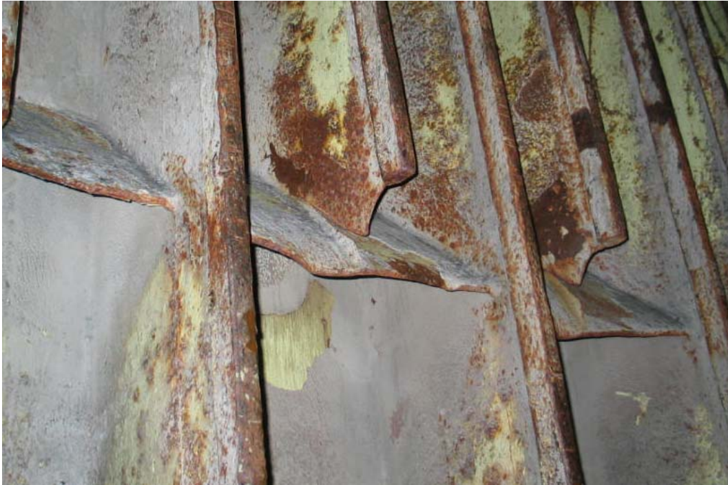
Kuva 2. Kauhakuormaaja/kahmari vaurioita jäykkäajissä
