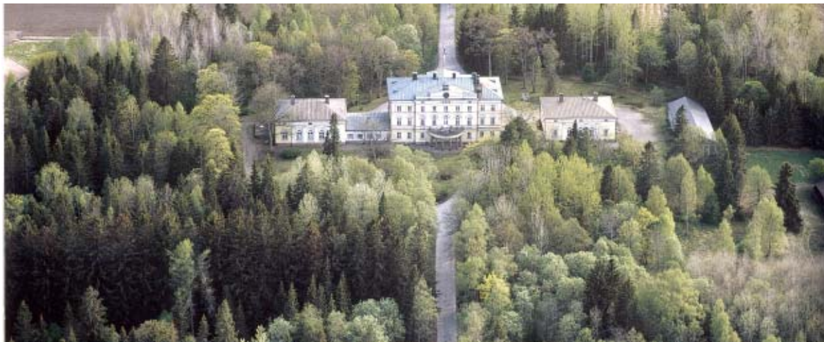
13. Joen yli johtaa puiden välistä suora tie kartanon päärakennuksen edustalle. Talon vastakkaiselta puolelta lähtee samaa linjaa noudattava tie Pistolan pihapiiriin. Päärakennuksen ja flyygelin väliin rakennettu nivelosa on purettu kunnostustöiden yhteydessä.
