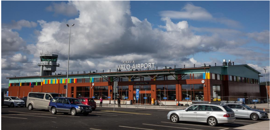
Kuvio 3. Ivalon lentoaseman uusi terminaalirakennus (Ivalo 2016)
