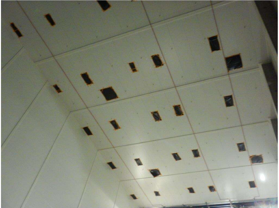
Kuva 8. Päätelaitteiden suojat, jotka eivät kuulu loppusiivousurakkaan. Suojat poistettiin tuntitöinä. Kuva: Virpi Kilpeläinen.
