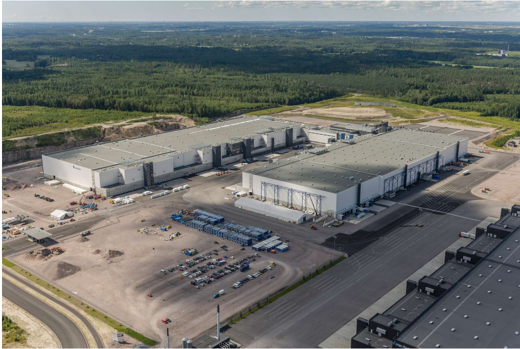
Kuva 2. PTDC-logistiikkakeskus. KUVA Haahtelan tietopankista.
